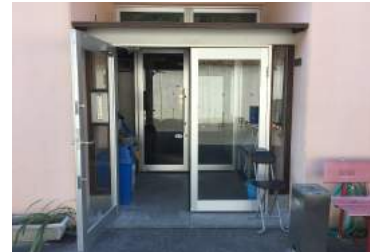
↑二重扉による風除室は、利用者さんからの評判も上々。
